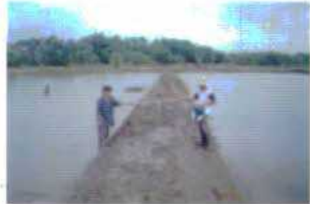
Gambar 2. Pematang tambak dengan kemiringan 1-1,5:1m
